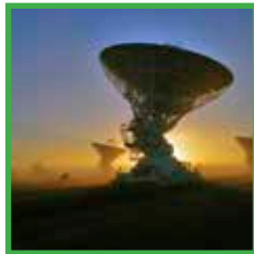
Sistemas de telecomunicaciones
